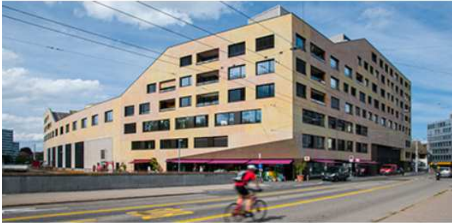
Wohn- und Gewerbebau Kalkbreite 2014
